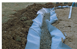
Réaliser un ouvrage de drainage
